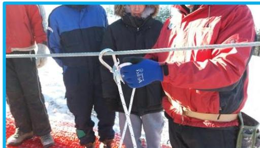
La distanza tra i due moschettoni possono cambiare in base all'altezza del palo, oppure se il Sistema è in una curva della pista.
