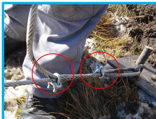
**Cavo Aereo** – Il cavo aereo dovrà avere la lunghezza della rete con una parte extra a monte e a valle, in modo tale da permettere il fissaggio agli ancoraggi.
